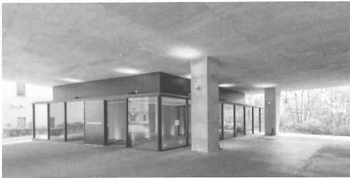
図 1.1-3 エントランスのピロティ(風の道)
