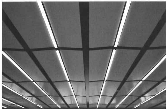
図 1.1-13 放射パネルの配置
