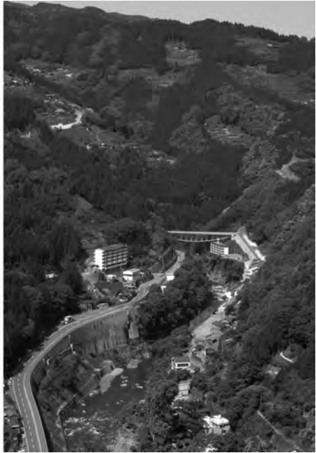
写真-3 谷を跨ぎ地域を結ぶ青雲橋。国際コンクリート連合の最優秀賞を受賞（徳島県三好市）
