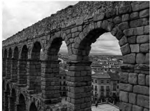
写真-4.3 水の移動 / セゴビア水道橋（スペイン） ローマ時代の石造アーチ橋。離れた水源地と都市を結ぶ水道
