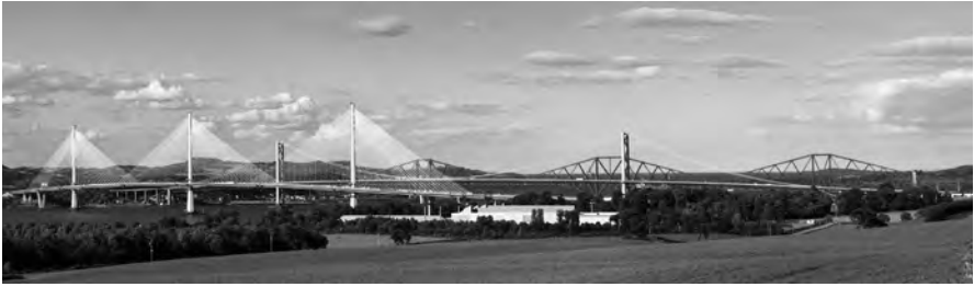
写真-4.1 フォース湾にかかる3世代の橋梁（英）（出典：istock.com/georgeclerk） 手前から2017年のクイーンズフェリー横断橋（道路橋）、1964年のフォース道路橋、1890年のフォース鉄道橋。それぞれの時代における社会ニーズと技術力の違いによって、3橋3様の橋が架かる
