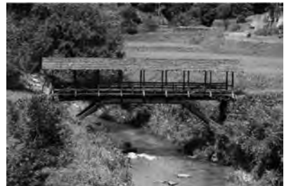
写真-5 田丸橋。屋根付きの方杖橋で、橋の上は荷物を置いたり食事や休憩時に寛ぐ場になっている（愛媛県内子町）
