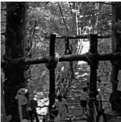
写真-4.2 人の移動 / 祖谷のかずら橋 現地発生材を用いた原始的な人道吊橋。現在は観光地として賑わい、数年ごとに架替えられている
