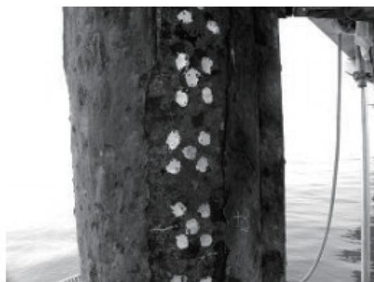
写真5.1 杭No.23の腐食状況
