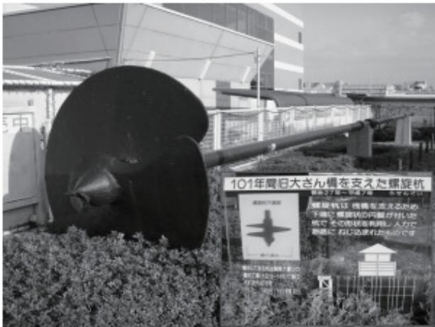
写真1.1 大桟橋の基礎に使用されたスクリューバイブル
